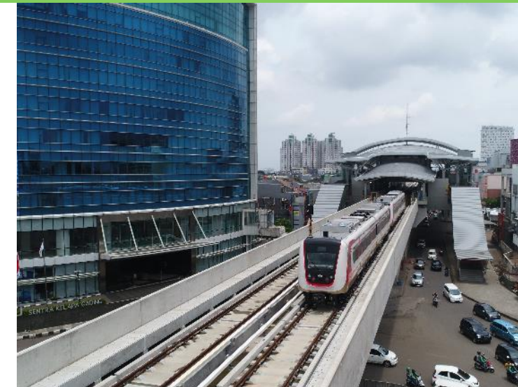
LRT Jakarta Fase 1B Velodrome - Manggarai
